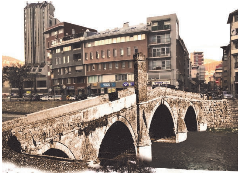
Фото-моншажа Касапчића моста
