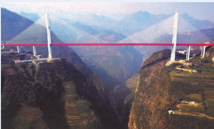
DUGE BRIDGE (BEIPANJIANG BRIDGE) (2021) МОСТ БЕЈПАНЃАНГ, ДУЖИНЕ 1,34 КИЛОМЕТАРА, СПАЈА ГРАД СЈУАНВЕЈ У ПРОВИНЦИЈИ ЈУНАН И ОКРУГ ШУИЦЕНГ У ПОКРАЈИНИ ГУЕЈЦОУ
